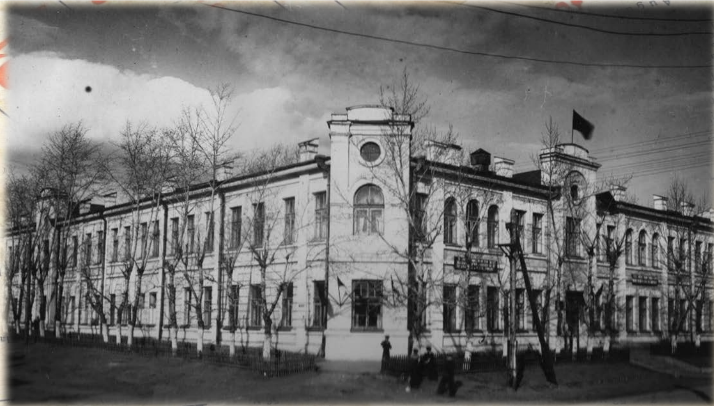
Главный корпус ЧГМИ, 1953 г.
