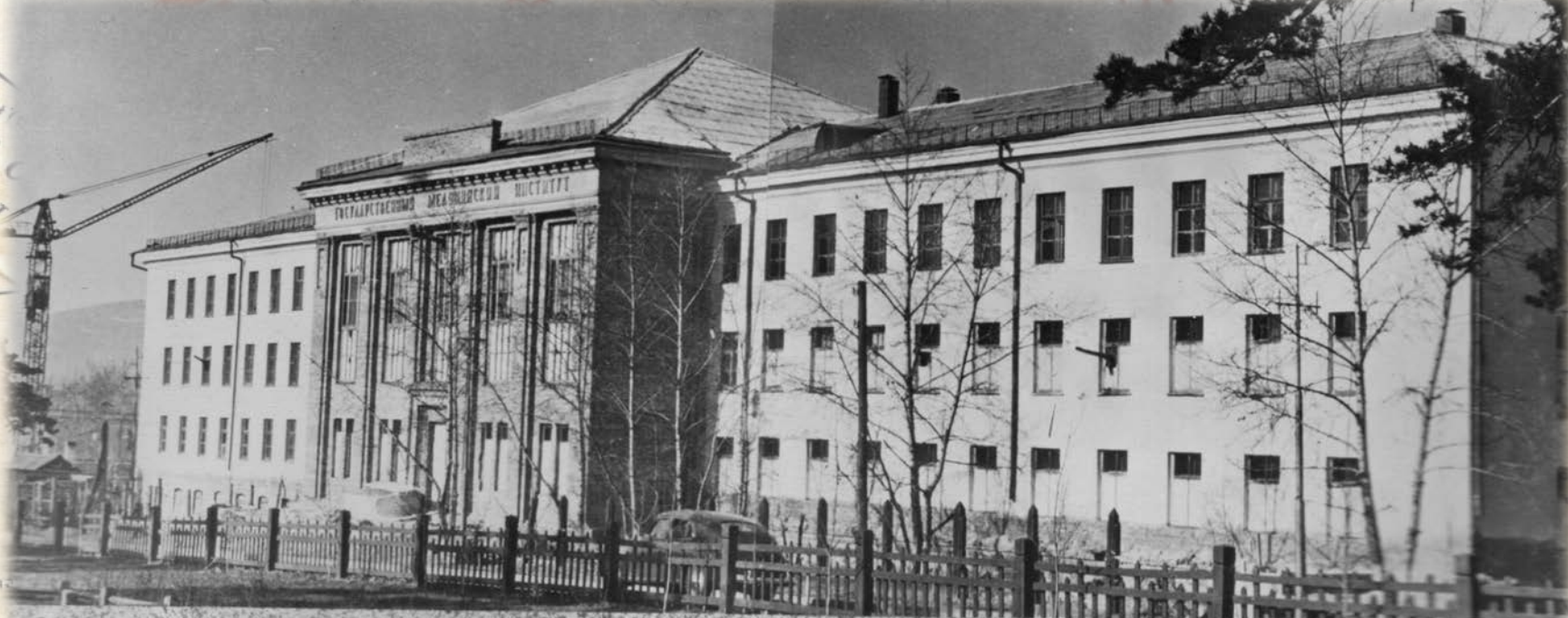
Главный корпус ЧГМИ 1962 г.
